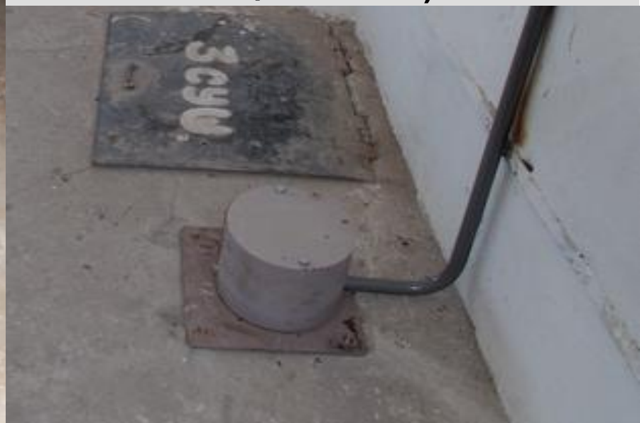
Установка датчиков уровня в узлы встройки закрытого типа.
